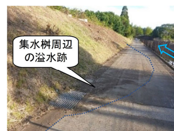
写真-2 管理用道路(左岸側) Management road (Left bank)
